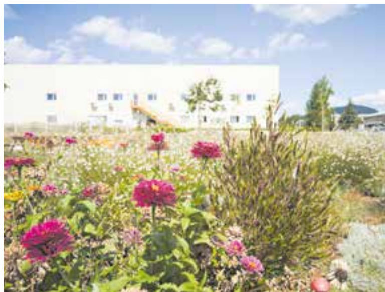
Exterior de l'Institut Les Garberes, ubicat al Pla de la Bruguera. || Q. PASCUAL
