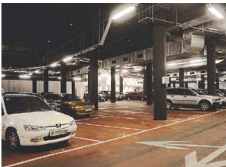
⊙ La primera planta de l'aparcament soterrat. || JOSEP GRAELLS
