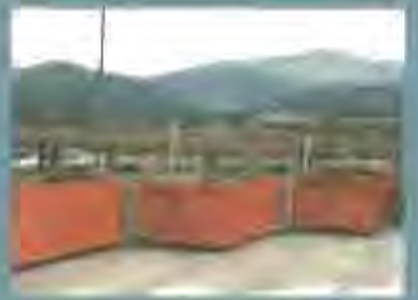
Obres de l'edifici de la Nau de Via Pública.
