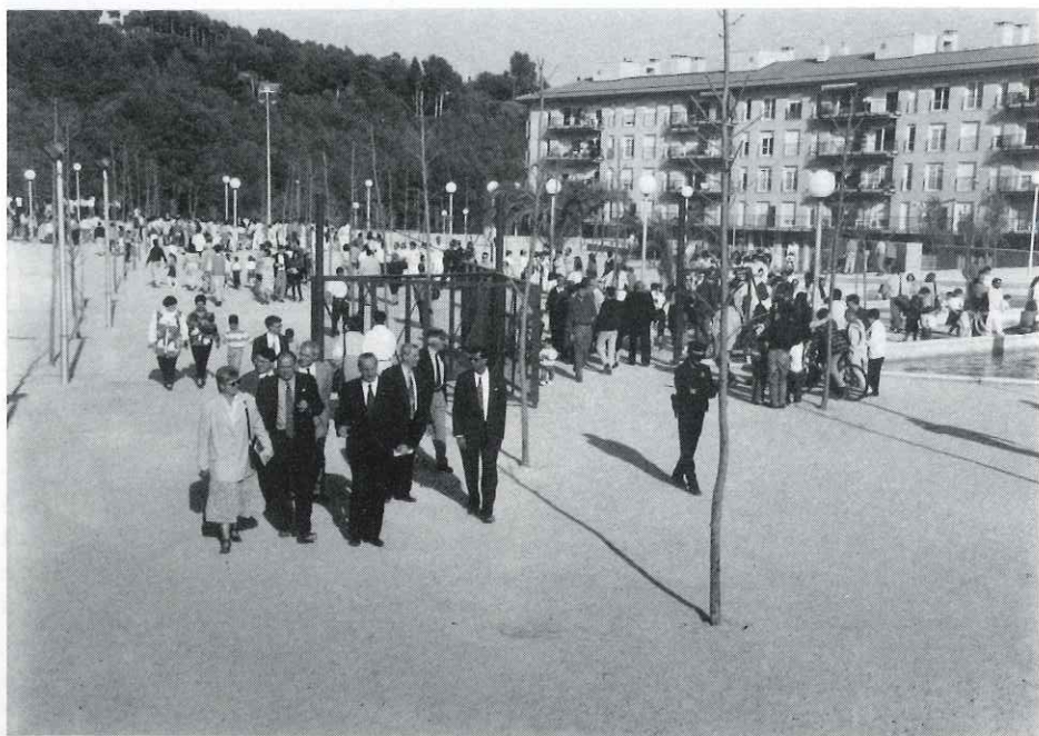
La plaça és obra de l'arquitecte castellarenc Pere Roca
