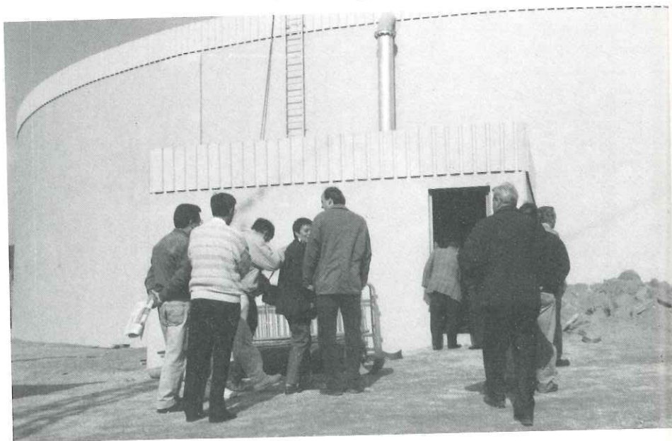
El dipòsit d'aigua de Canyelles entrarà en funcionament aquest mes
