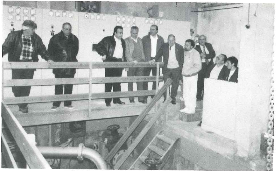
Amb la compra de les instal·lacions de Calama, S. A., queda assegurat el subministrament d'aigua a la vila durant 25 anys
