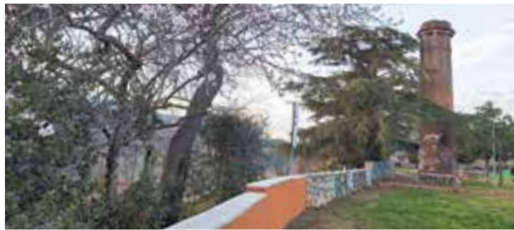
Part del mur que s'ha reparat entre ronda Turuguet i plaça de la Miranda. || CEDIDA
