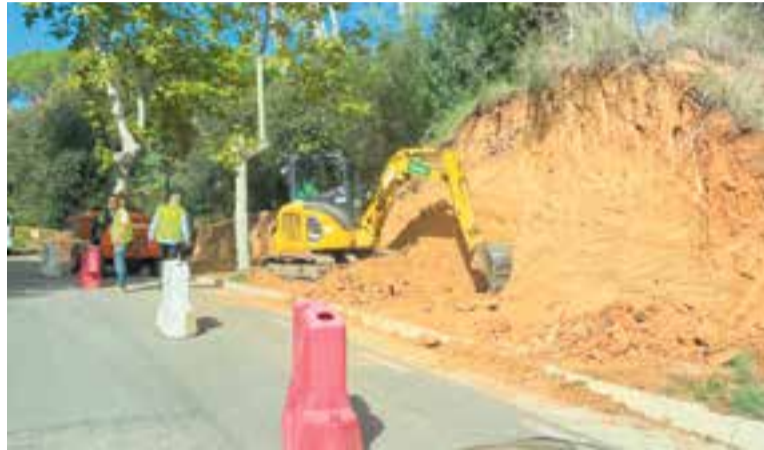
Ja han començat les obres de la segona fase del camí bici. || AJ. CASTELLAR
