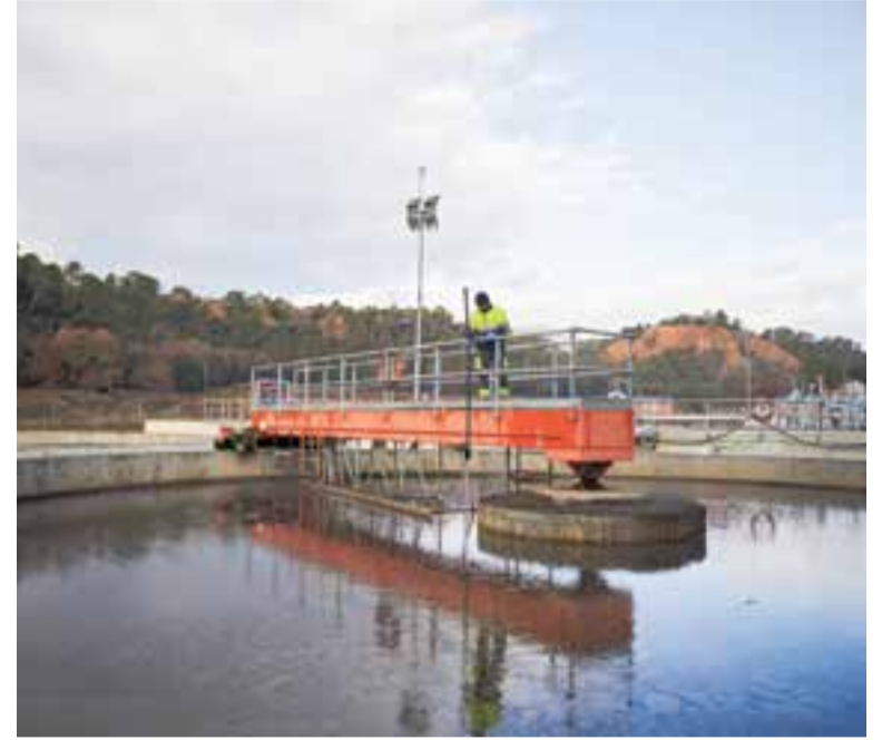
Un operari a les instal·lacions de l'EDAR de Castellar el gener passat. |IQ. PASCUAL
