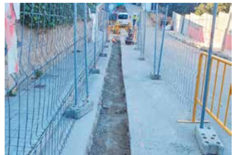
Un detall en què es troben els treballs de renovació del clavegueram. || AJUNTAMENT
