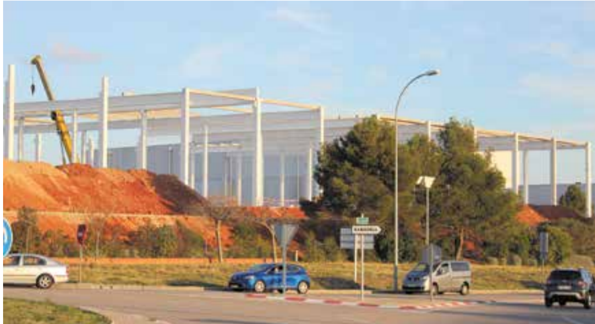
La construcció de la nova plataforma de Tech-Stone avança a bon ritme i ja s'estan aixecant els pilars i bigues. || A. LLOR
