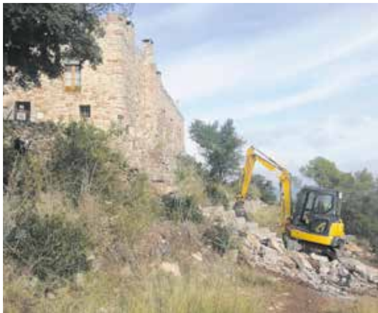
Una màquina actuant al mur de pedra que envolta el Puig de la Creu. || CEDIDA
