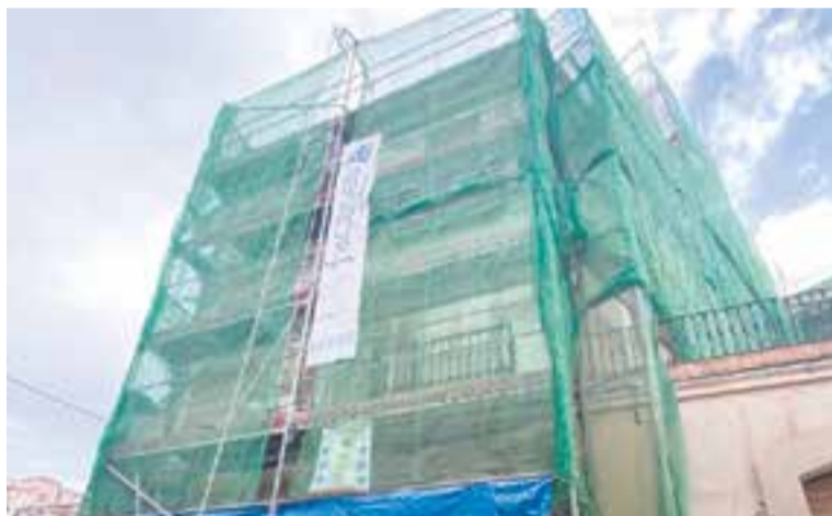
Nou asfaltat a l'av. Sant Esteve i obres a la façana del Centre d'Estudis | AJ. CASTELLAR
