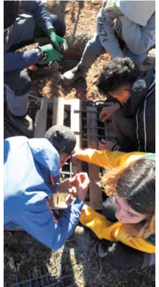
© Preparació dels fonaments armats.
