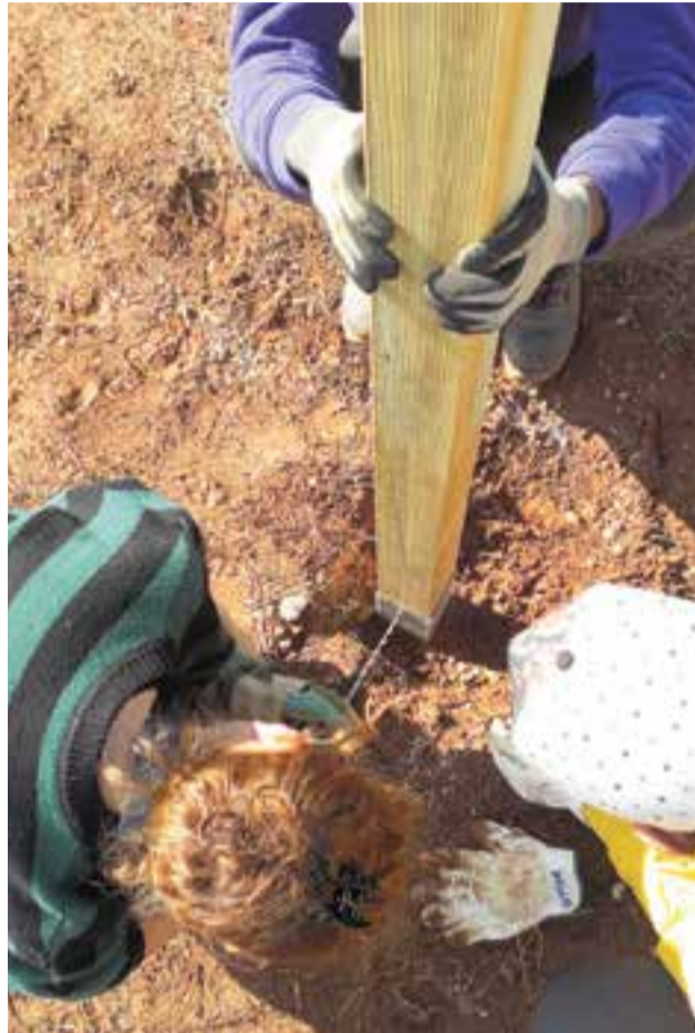
© Col·locació de pilars.
