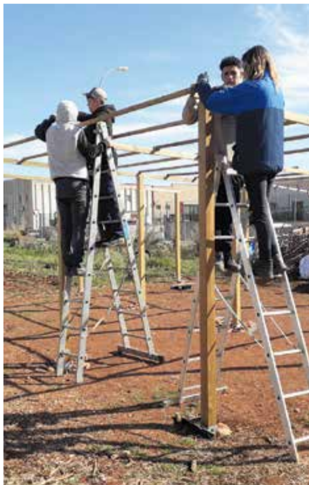
© Col·locació de cabirons (listerons).
