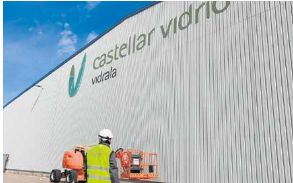
Un detall de la planta de Castellar Vidrio, on s'hi col·loquen 10.000 plaques a les cobertes de les instal·lacions. || CEDIDA
